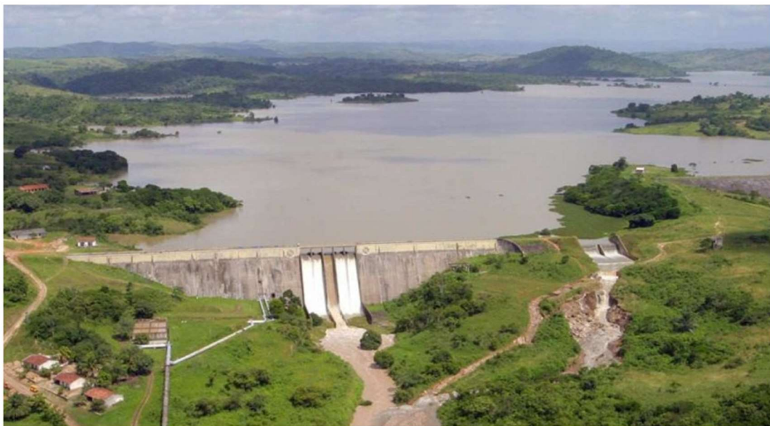
Barragem de Tapacurá, em São Lourenço da Mata, faz parte do Sistema de Contenção de Cheias do Rio Capibaribe - FOTO: COMPESA
